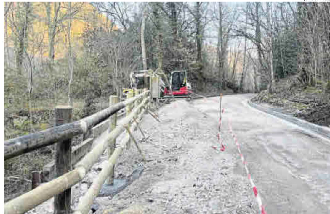
La senda de Muñigu a Covadonga, en obras.
